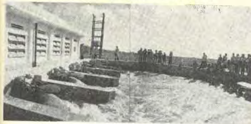
Trạm bơm Phú Hòa (An Giang)
