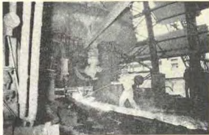
Xưởng luyện thép Lưu xá đang cho thép rã Выпуск стали на металлургическом заводе Лью Са Steel pouring in steel making plant Lưu Xa
